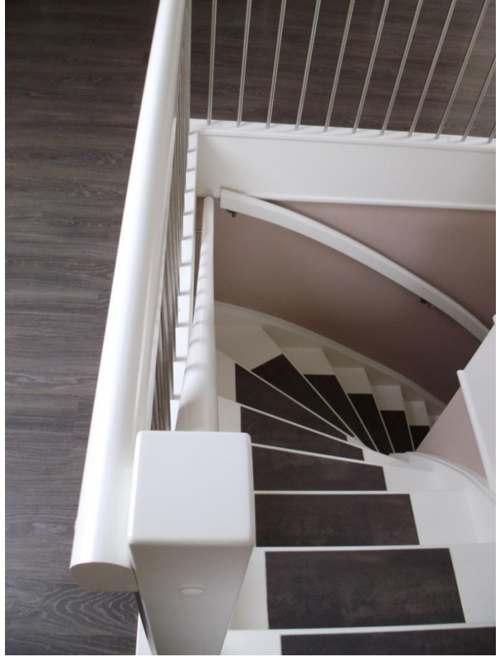
Eine elegante Optik vereint mit hoher Strapazierfähigkeit durch eingearbeitete Bodenfliesen in der Trittstufe
