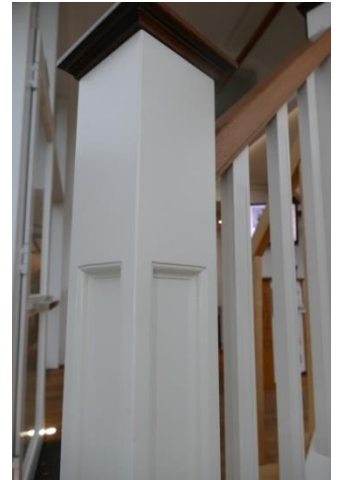
Pfosten mit eingefräster Tasche und profilierter Kappe:
