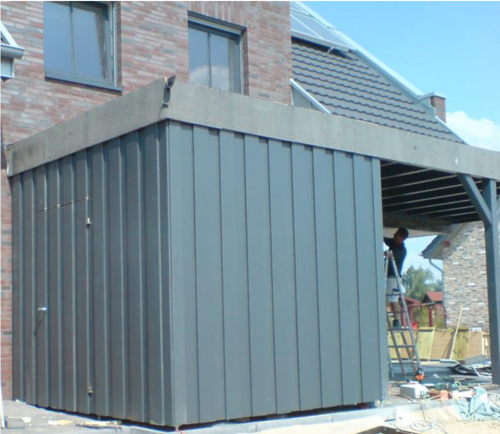
Carport in Kombination mit einem Geräte- und Fahrradschuppen mit Fichte RAL-lasierter Boden Deckel Schalung verkleidet.
